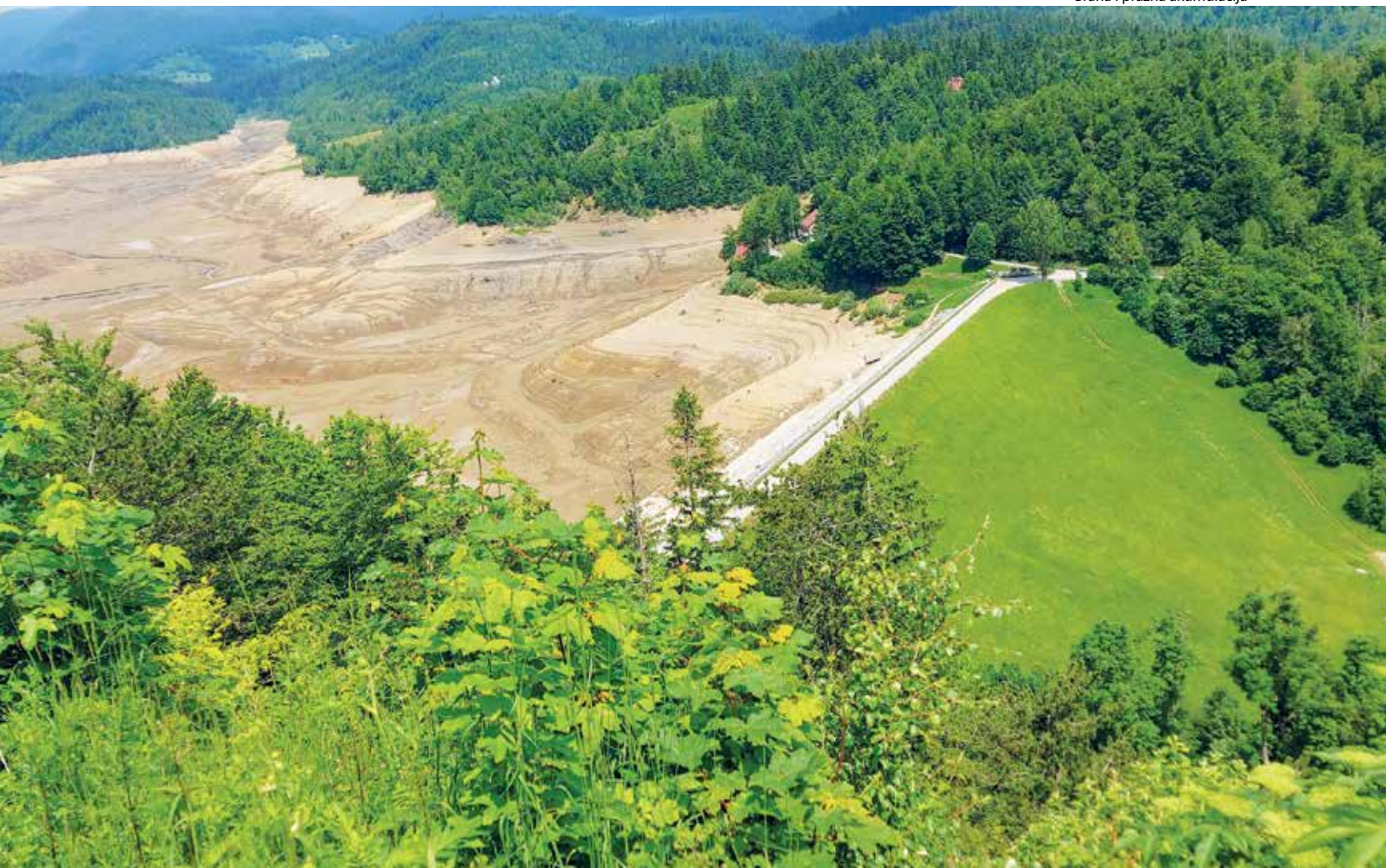
Brana i prazna akumulacija
