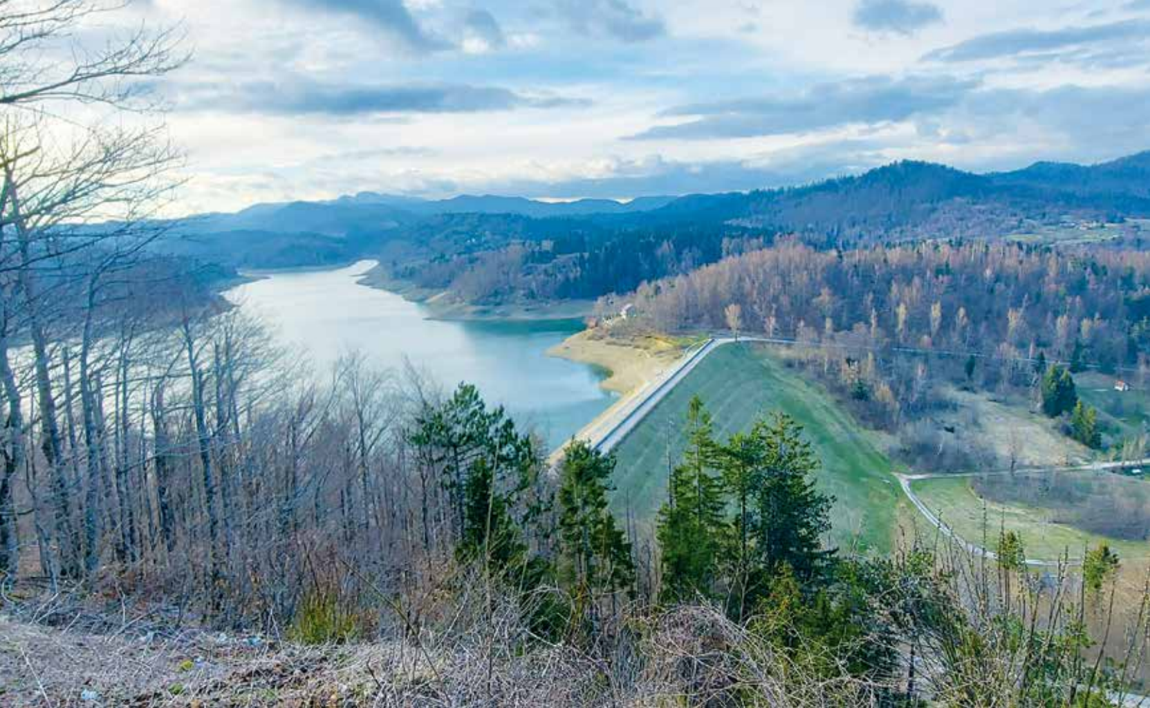
Brana i puna akumulacija prije pražnjenja
