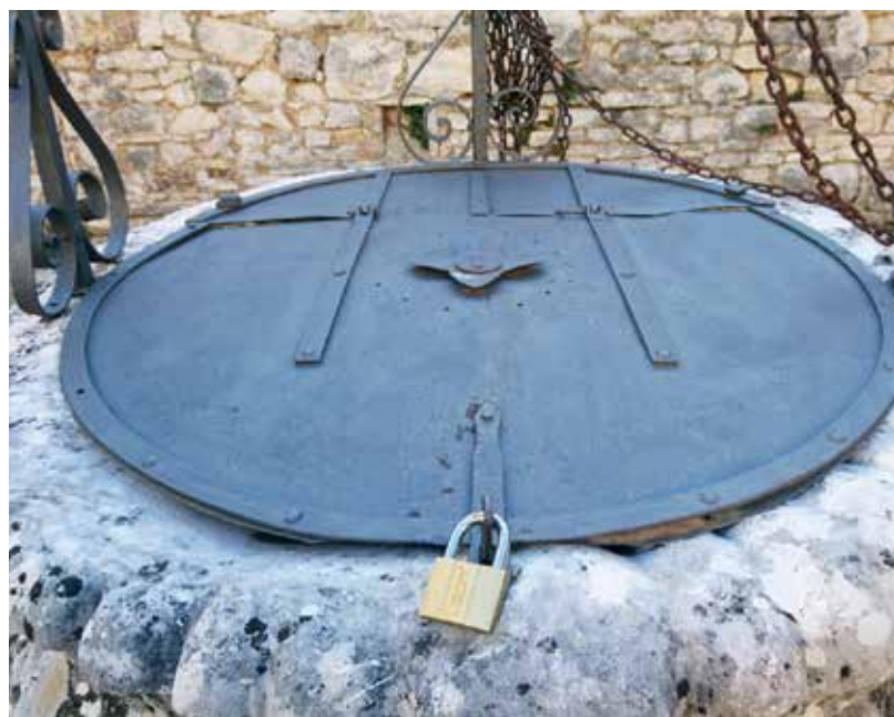
Na rubovima su ostali tragovi od lanca za izvlačenje sića s vodom iz šterne
