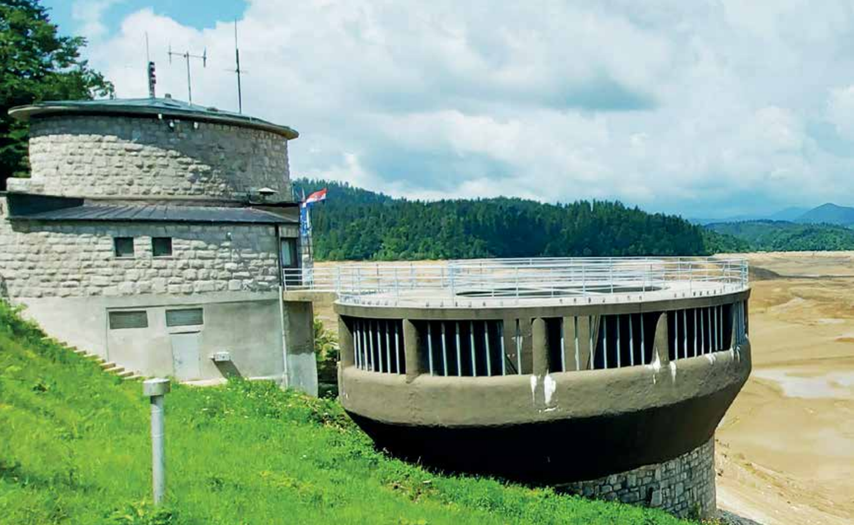
Brana, preljev i zatvaračnica
