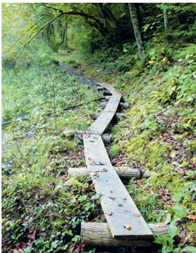
Potopljeni dijelovi staze su prohodni zahvaljujući ovim jednostavnim mostićima
