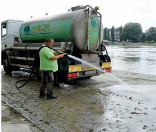
Nakon prolaska velikog vodnog vala na Dravi kroz Osijek koji je poplavio lijevu obalu rijeke i šetalište na dijelu Promenade ostala je dosta velika količina pijeska i mulja, koje se više dana čistila i prala
