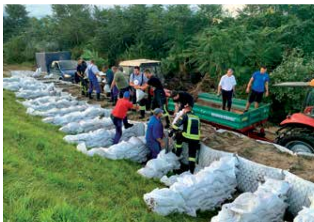
Osiguranje stabilnosti nasipa vrećama - Hrušćica (foto Z. Đuroković)
