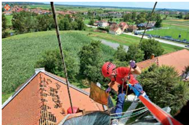
Sanacija krovova nakon nevremena
