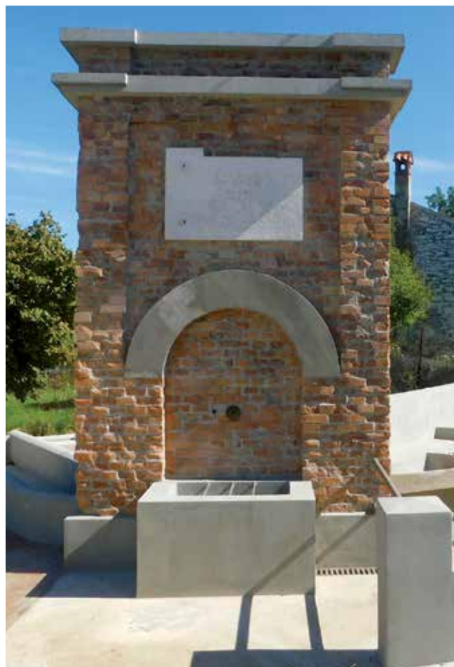
Obnovljena stara česma u Materadi
