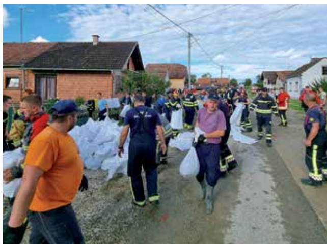
Gradnja zečjih nasipa u Drnju (foto Ž. Bukša)
