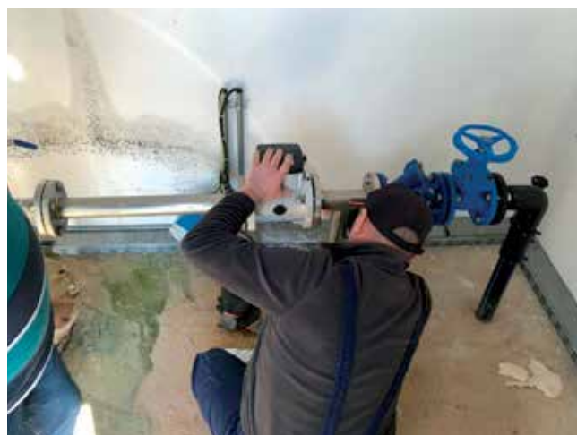
Jedan od prvih mjernih uređaja iz projekta ugrađen je na Pagu - vodovod Povljana
