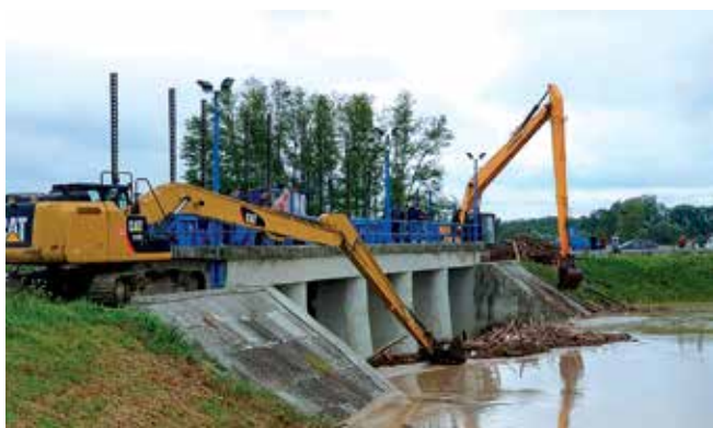
Interventno čišćenje naplavina na ustavi Prevlaka (foto Z. Đuroković)
