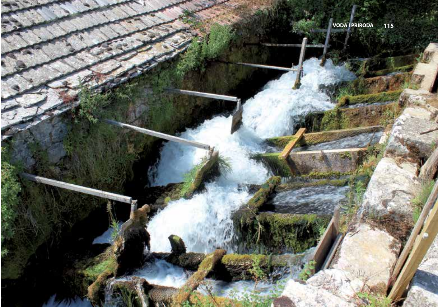
Vanjsko postrojenje Samardžića mlinice
