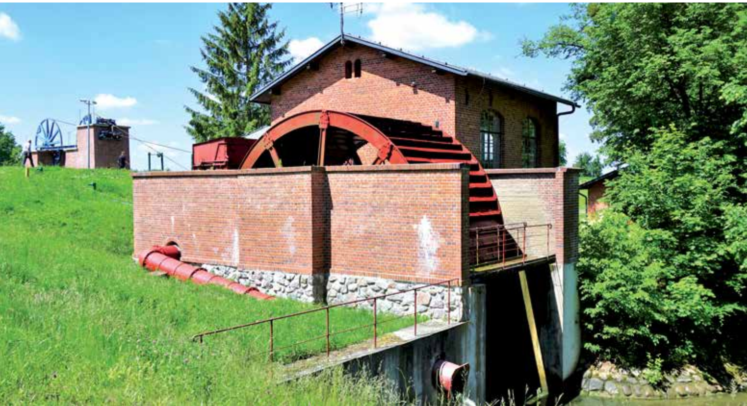
Strojarnica koja pokreće čeličnu užad za vuču platformi, Katy
