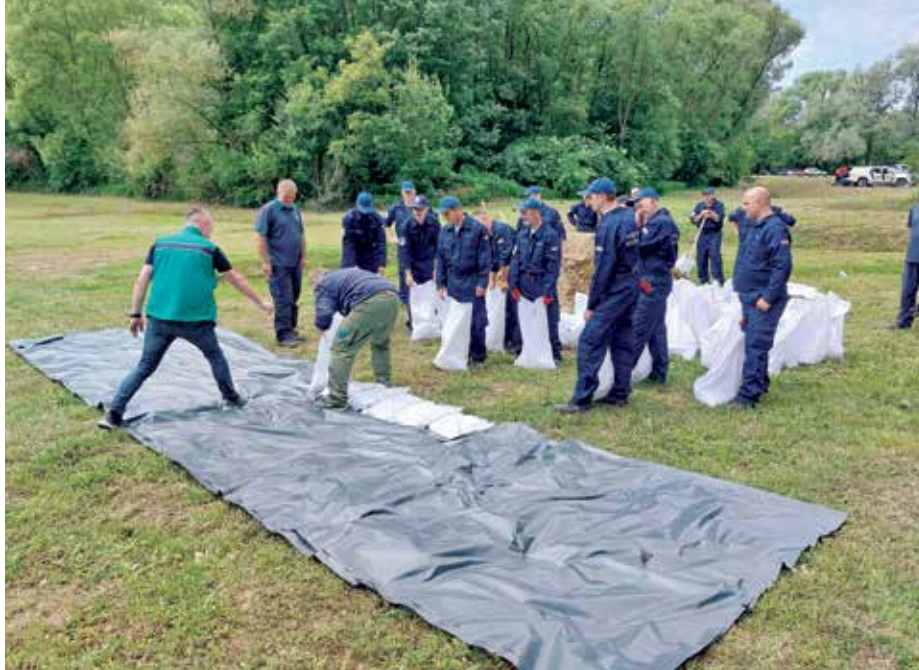
Izgradnja zečjih nasipa uz edukaciju Hrvatskih voda
