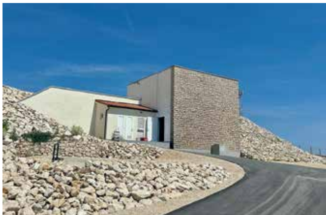
Vodosprema Komorovac I
