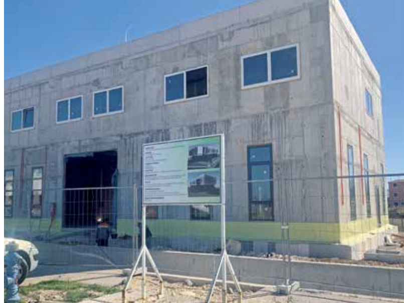
Centar obrane od poplava u izgradnji
