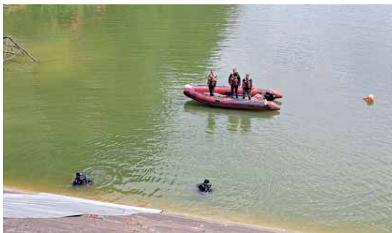
Postavljanje geomembrane na brani, ronionci u suradnji s Hrvatskim vodama
