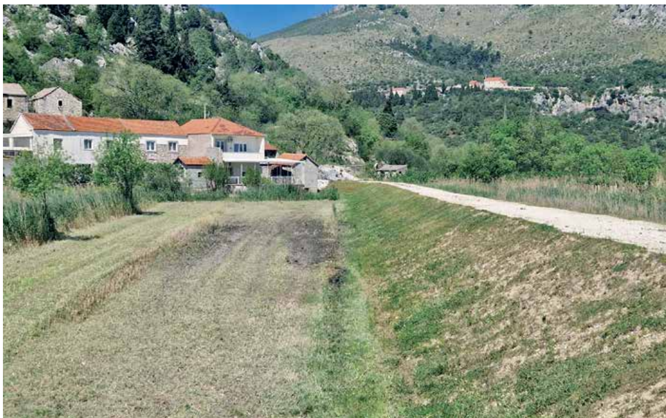
Izgrađeni nasip obrane od poplava dijela naselja Krvavac
