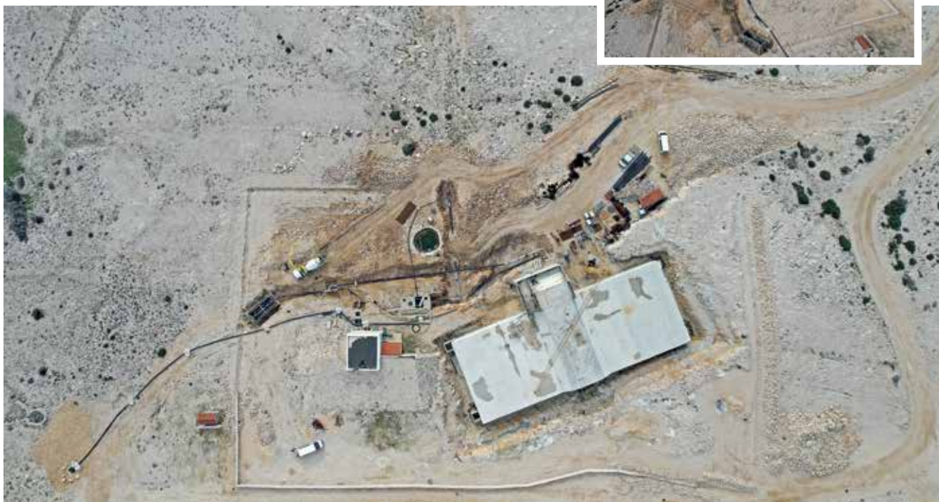
Izgradnja vodospreme Komorovac II
