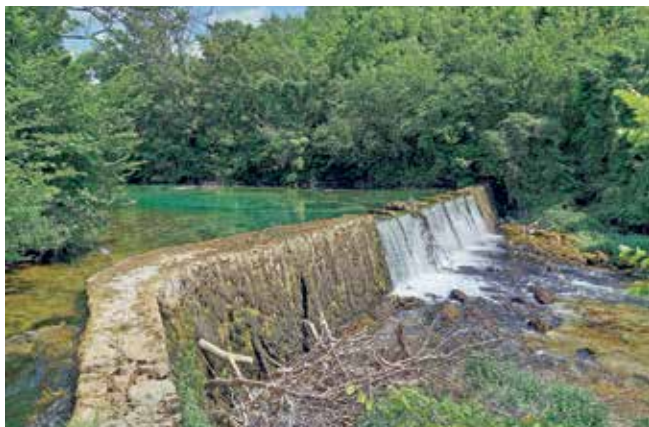
Bent za navođenje vode na mlin
