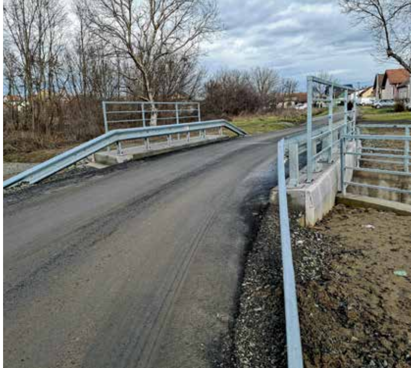
Izgrađeni AB sandučasti propust na potoku Potočani
