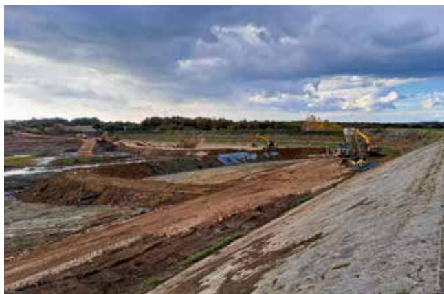
Izgradnja zagata i precrpnog bazena
