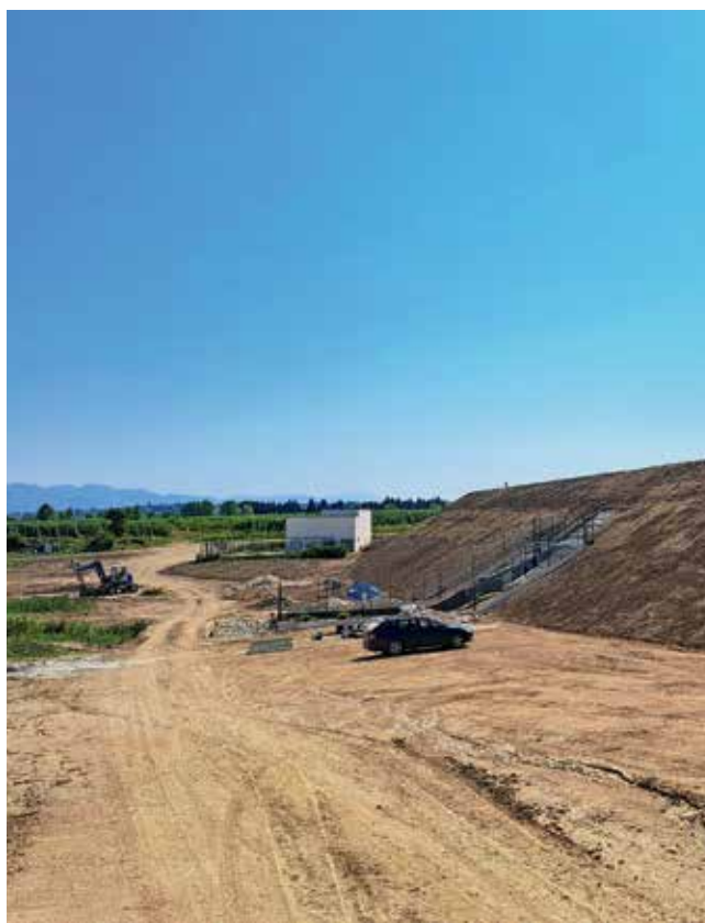
Završno uređenje nizvodnog pokosa
