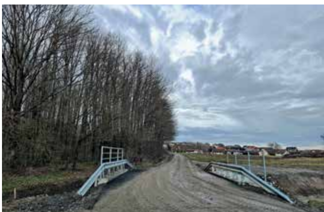
Izgrađeni AB sandučasti propust na potoku Stublovac
