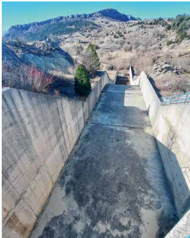
Brzotok na lijevom boku glavne brane
