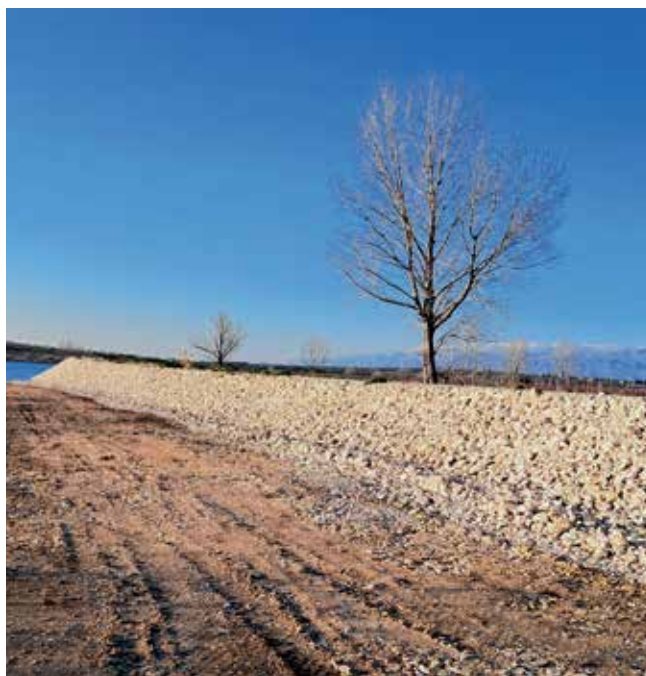
Zamjena kamene obloge uzvodnog pokosa
