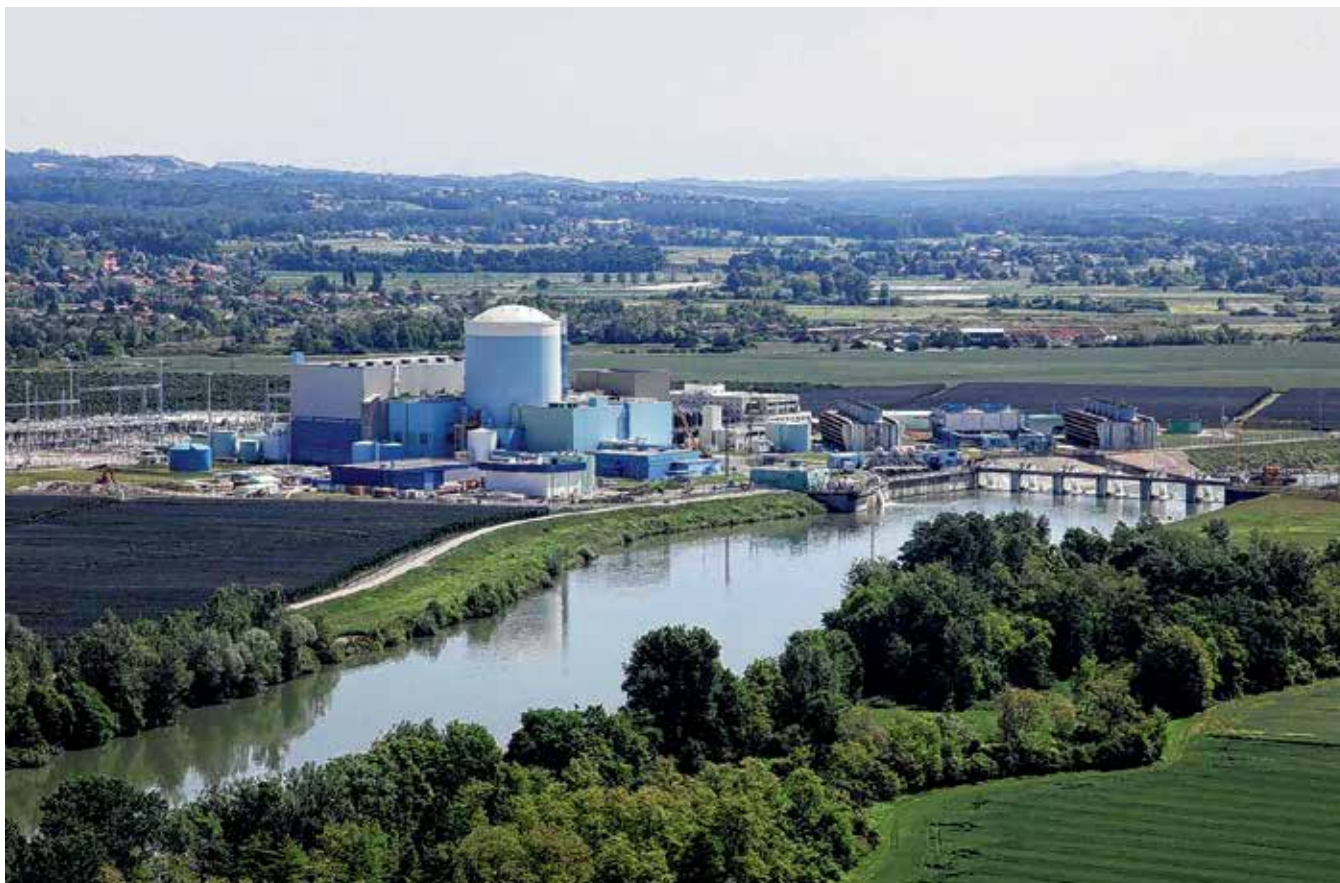
Pogled na NE Krško i HE Brežice ( https://hr.wikipedia.org/wiki/Nuklearna_elektrana_Krsko , snimljeno: 19.11.2019.) (PIXSELL)
