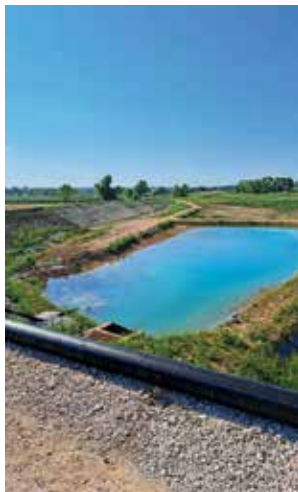
Privremeni cjevovod DN 250 mm i precrpni bazen
