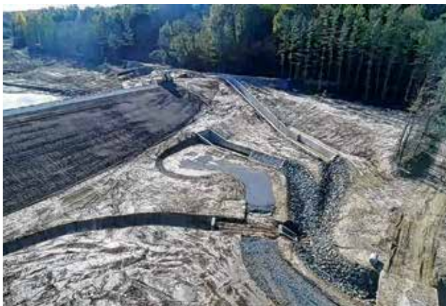
Izgrađene evakuacijske građevine retencije Stublovac
