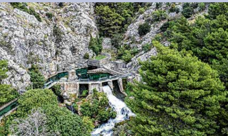
Lokacija izgradnje i gabariti pročišćivača pitke vode ovaj projekt čine složenim i zahtjevnim
