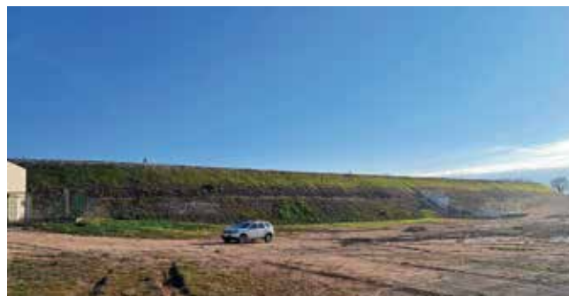
Završna faza rekonstrukcije brane
