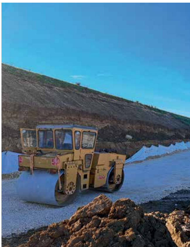
Ugradnja kamenog materijala na nizvodnom pokosu
