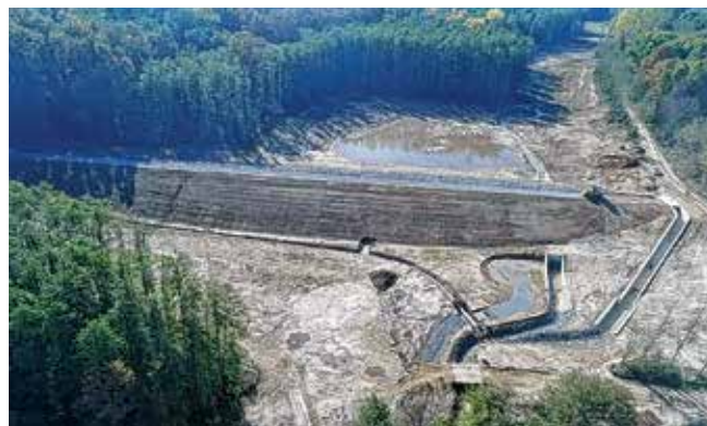
Snimak iz zraka izgrađene retencije Stublovac sa zaplavnim prostorom
