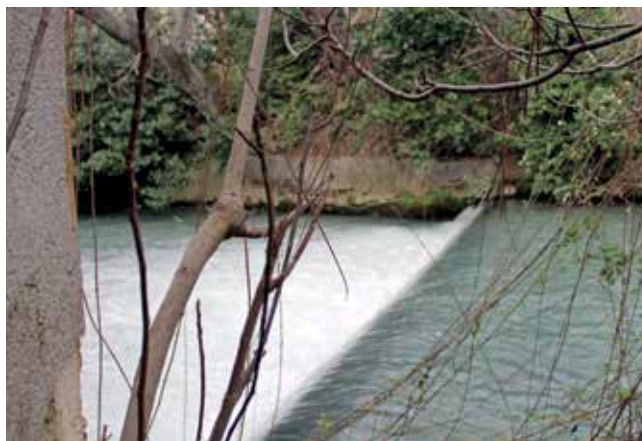
Pregrada kod Cementare, Jadro
