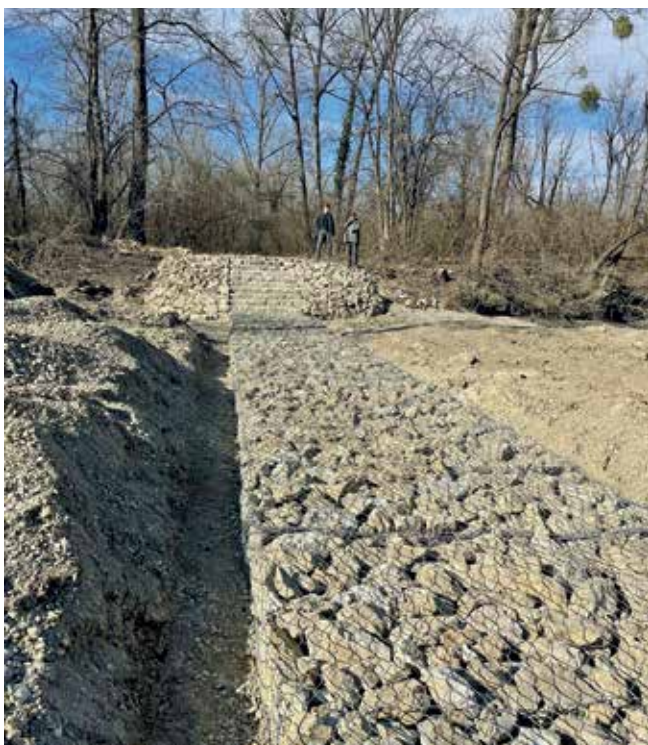
Gabionski prag kao dio budućeg edukacijskog puta od vodnog centra preko rukavca do vidikovca i obale Drave
