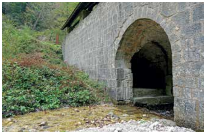
Putrihove klavže - portal koji se nekada zatvarao s drvenim vratima u svrhu stvaranja akumulacije
