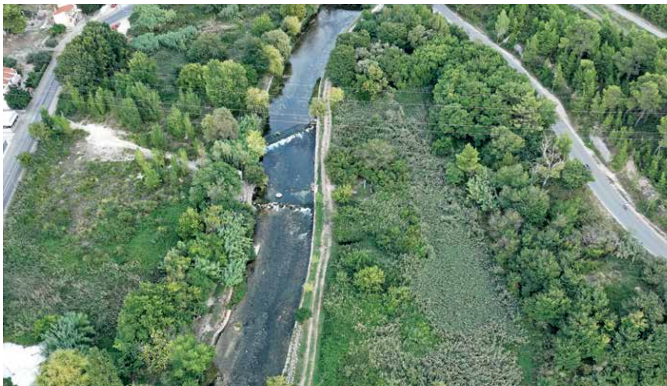
Pregrade na rijeci Jadro
