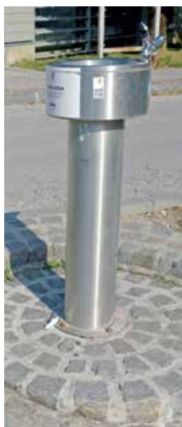
Javna česma postavljena u sklopu projekta Voda iz pipe – pijte jo vsak dan
