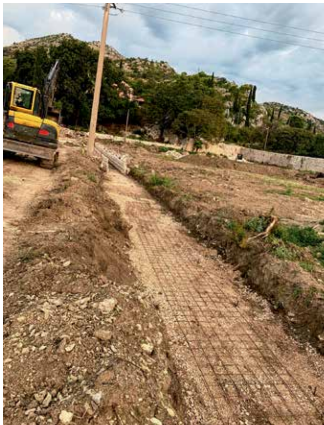
Tamponiranje i armiranje temelja sabirnog kanala
