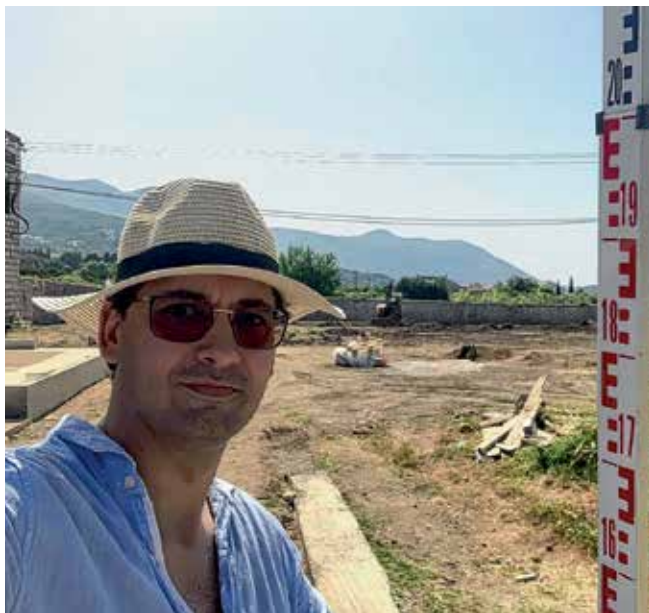
Kontrola visina u svrhu postizanja pravilnog i propisanog pada
