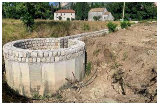
Betoniran i djelomično obložen Bunar
