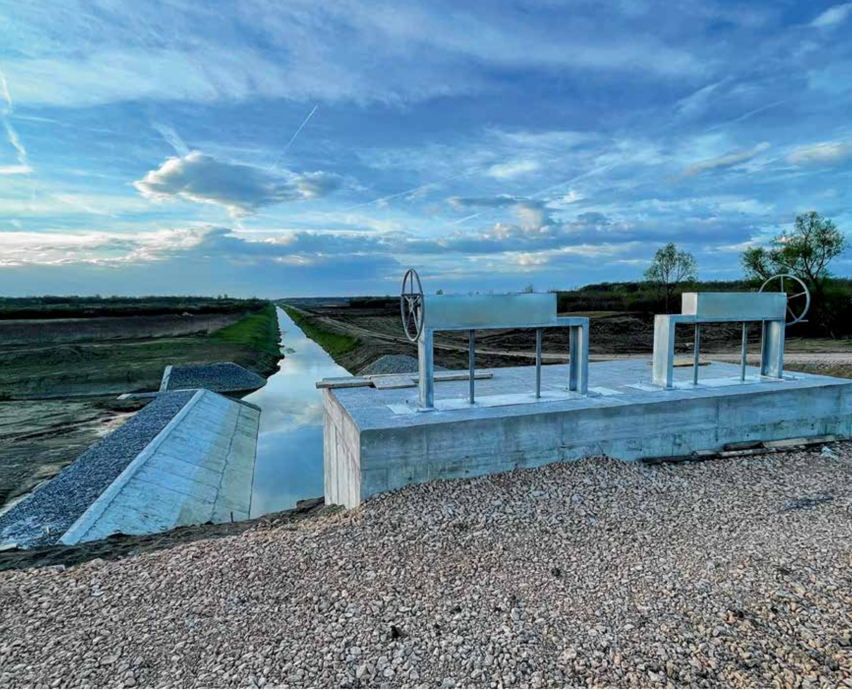
Izgrađena velika ustava
