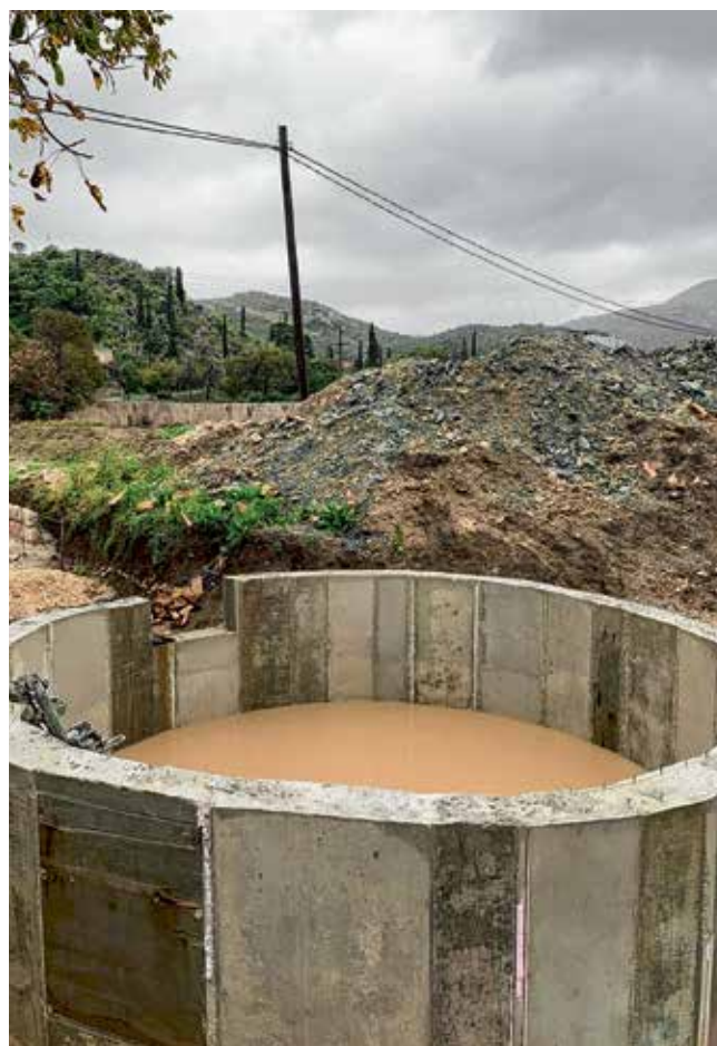
Testiranje drenažnog sustava i bunara nakon jače kiše
