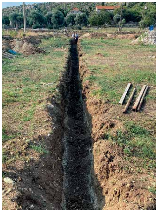
Zemljani iskop kanala za drenažu
