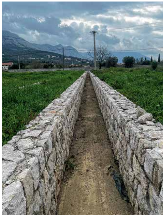
Izgrađen sabirni kanal
