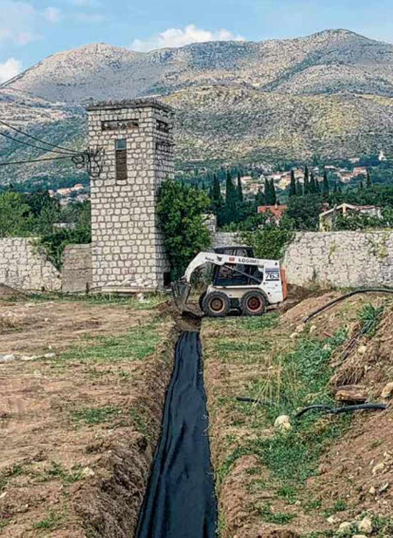
Zaštita kamenog nabačaja geotekstilom
