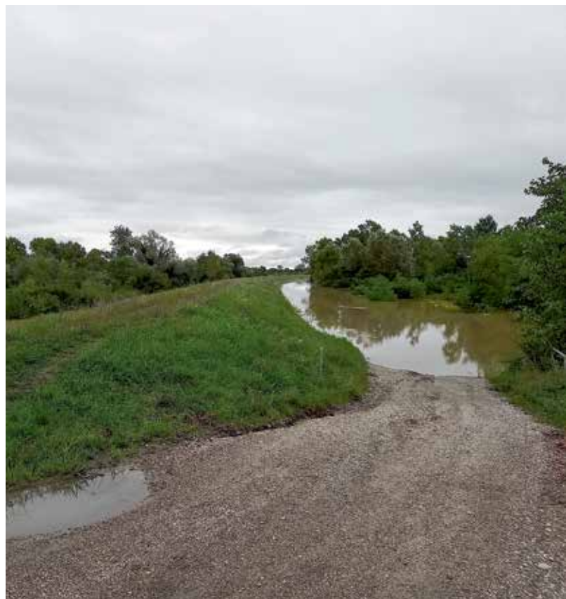
Rekonstrukcijom nasipa povećat će se sigurnost od poplava i ujednačiti stupanj zaštite s nizvodnim i uzvodnim dionicama na području od Zagreba do Siska
