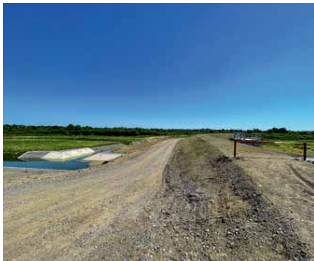
Izgrađeni nasip kod velike ustave
