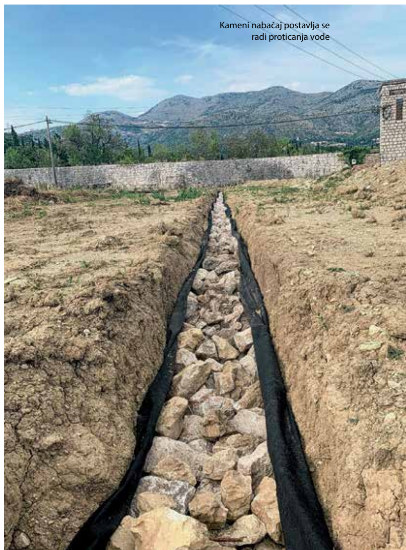
Zemljani iskop kanala za drenažu
