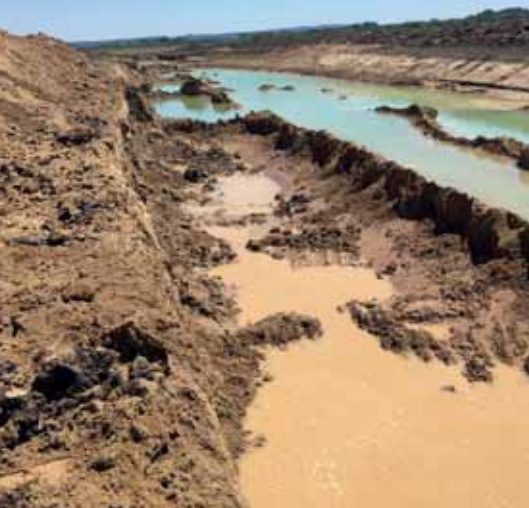
Dionica Klakar-Ruščica, nasipavanje materijala u tijelo berme
