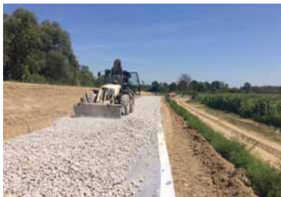
Izgradnja savskog nasipa u Sunjskom Selištu
