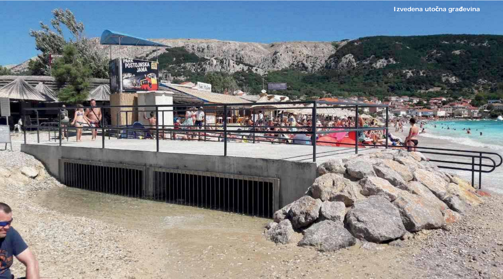
Pogledi na izvedenu utočnu građevinu s rampom za invalide
