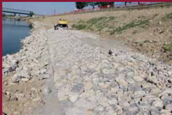
Radovi na obaloutvrđi u Slavonskome Brodu. Izvor: http://www.slavonski-brod.hr/index.php
